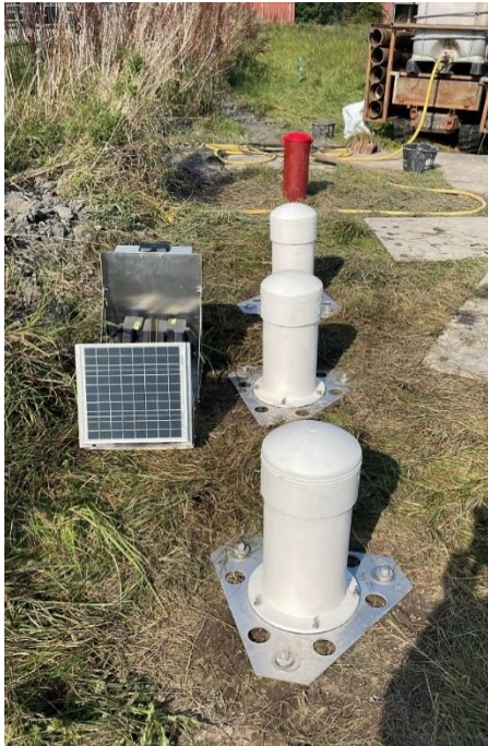
Figuur 4: De TNO meetopstelling zoals deze bovengronds te zien is bij museum Wierdenland. De rode kap bevat peilbuizen en de witte kappen extensometers.
