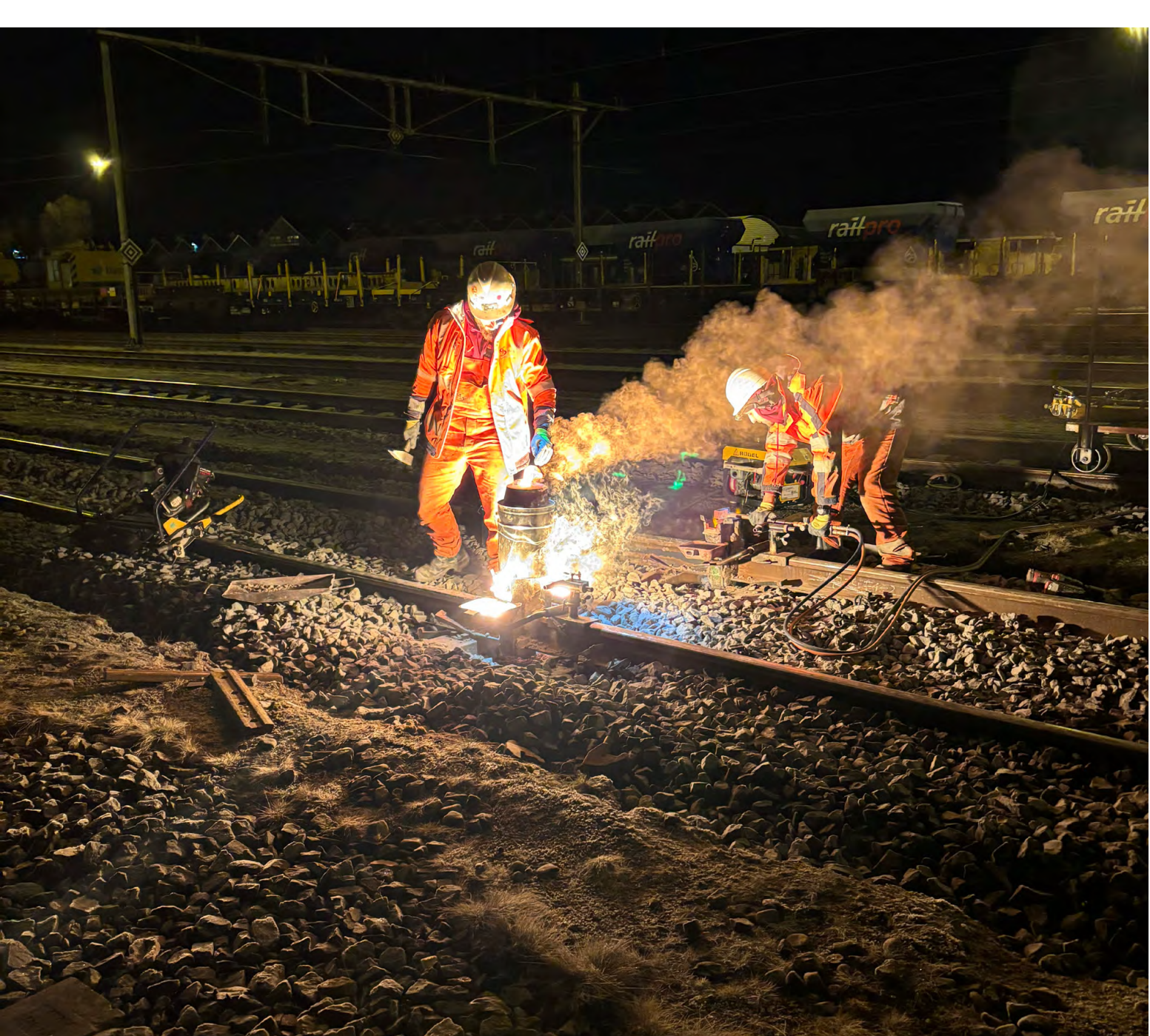
Nachtwerk aan het spoor. Foto: Nederlandse Arbeidsinspectie
