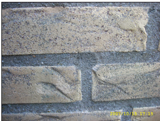
Afb. 3 Boorgat in de gevel
