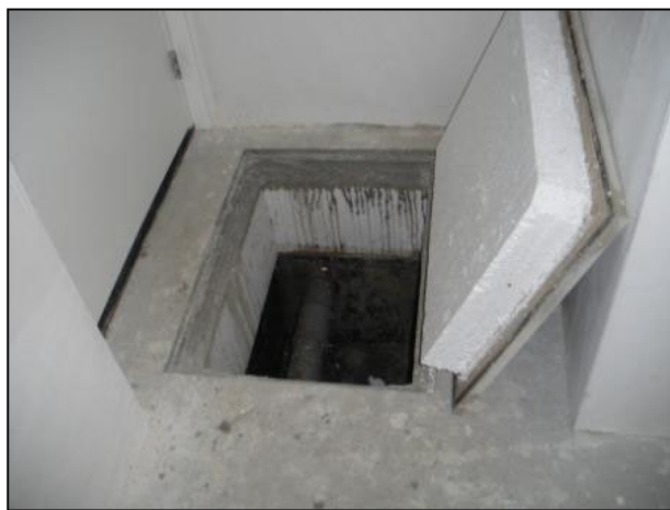
Afb. 7 Isolatie in de vloer
