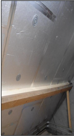
Afb. 6 Isolatie op vlkering tussen de gordingen
