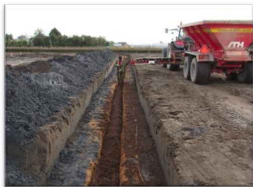
Figuur 9. Met ijzerzand omhulde drain
