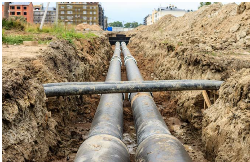
De aanleg van een warmtenet.
