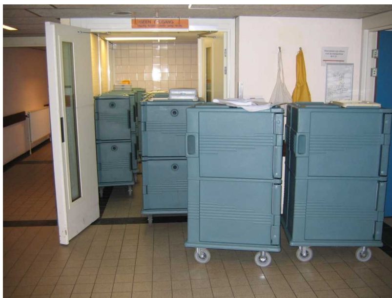
Foto 18: In geopende stand geblokkeerde, zelfsluitende deuren in brandscheiding.
