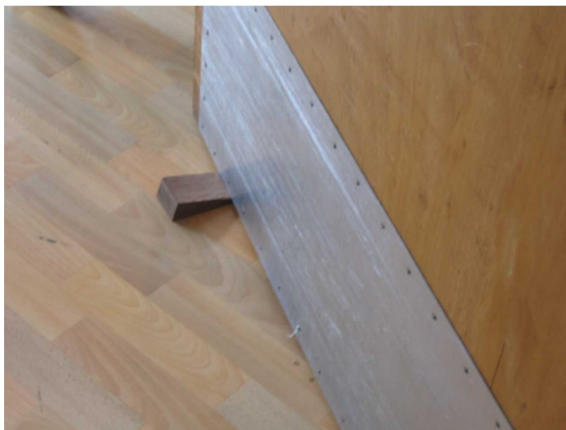
Foto 17: In geopende stand vastgezette, zelfsluitende deur in brandscheiding.
