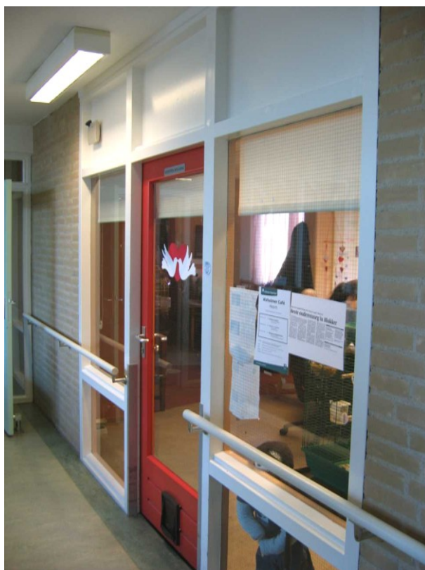
Foto 10: Kunststof kattenluikje in niet-zelfsluitende deur en te veel draadglas in brandwerende scheiding.
