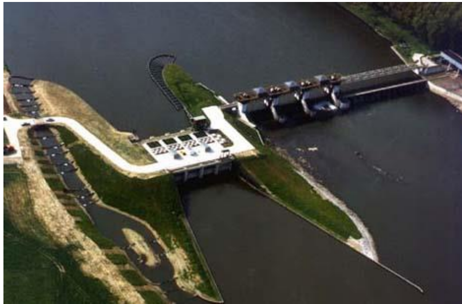
Figuur 5 Waterkrachtcentrale Linne in de Maas. Bron: (Microhydropower.net, sd)
