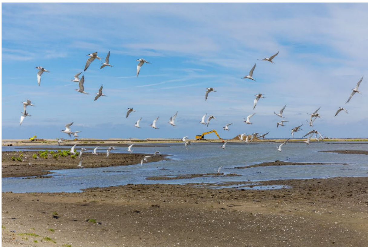
Aanleg Markerwadden (foto: Jasper Doest, Boskalis)
