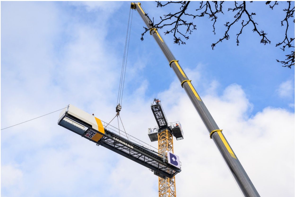
Installatie torenkraan
