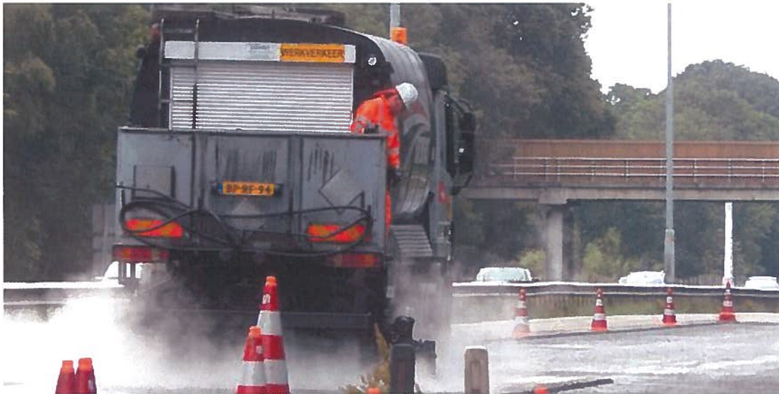
Figuur 9.1 Nieuwe asfaltoverlaging
