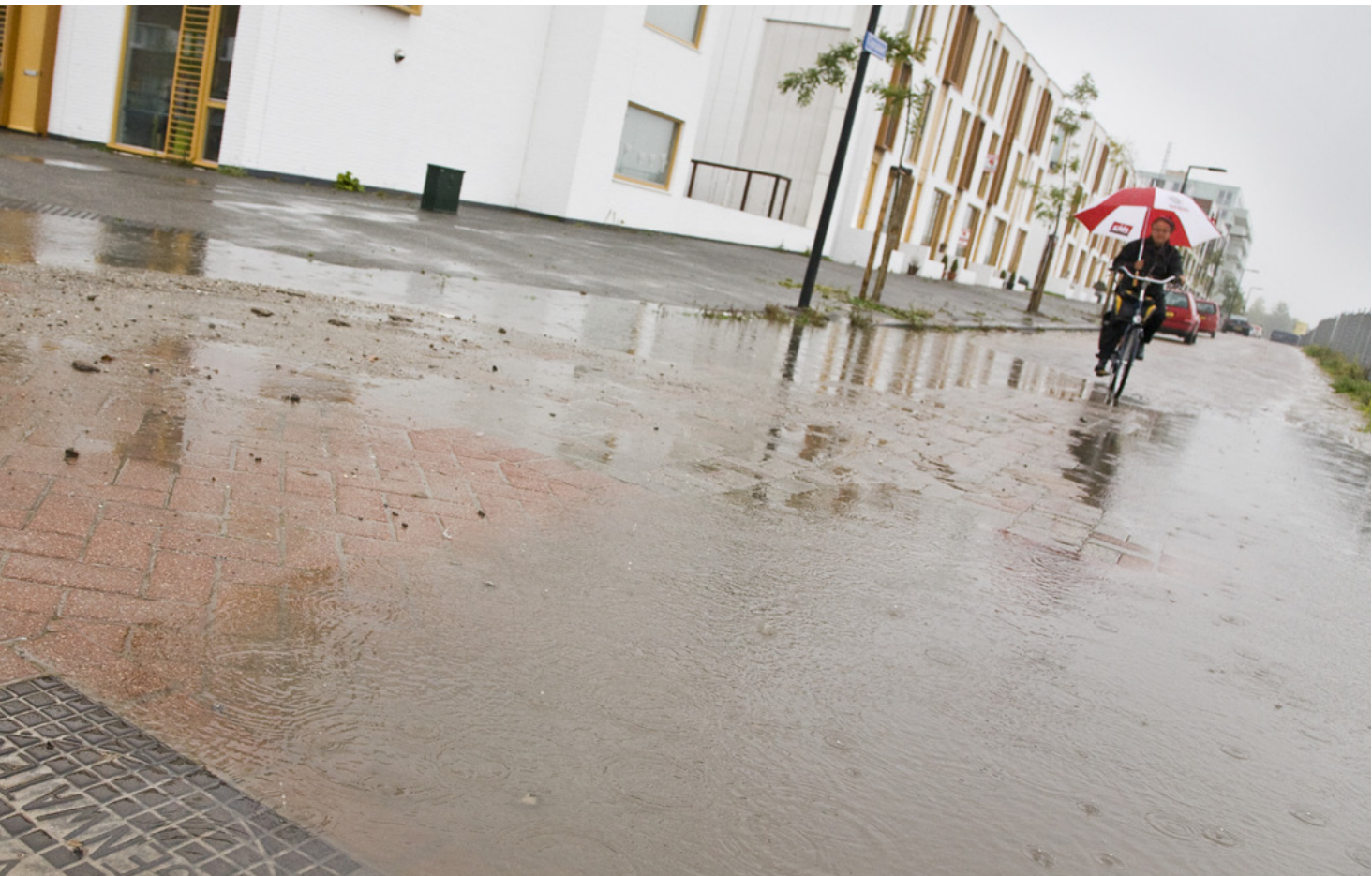
Tijdens een wijkshow zullen deskundigen van de gemeente en de verzekeringsmaatschappij de situatie ter plekke beoordelen. FOTO: HENRI CORMONT/INZICHT-FOTO
