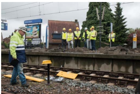
aanleg ATB-Vv bij Gilze-Rijen
