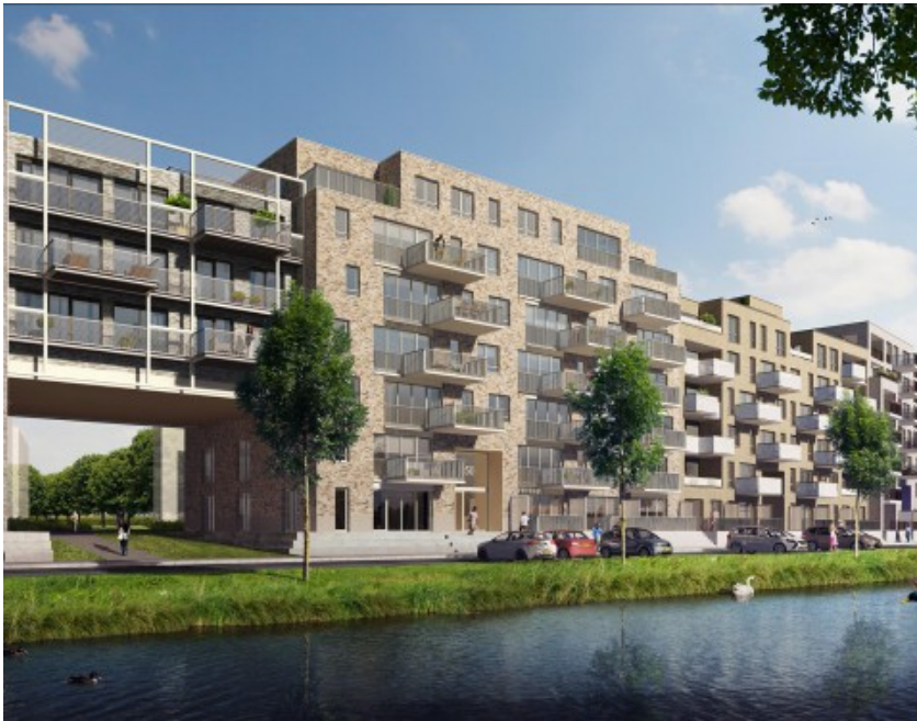
Figuur 8 Y-city; voorste pand met poortgebouw is blok 15 www.justarchitects.eu
