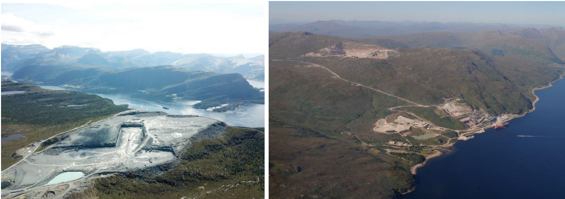
Afbeelding 3.1 Bremanger steengroeve, Noorwegen (links) Glensanda steengroeve, Schotland (rechts)
