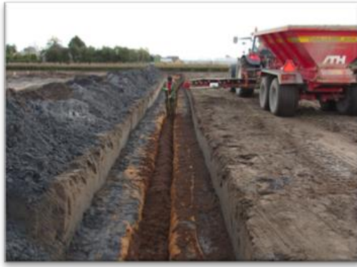
Figuur 9. Met ijzertzand omhulde drain
