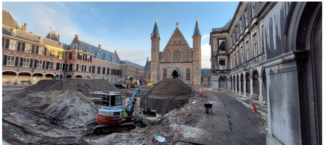
Werkzaamheden Opperhof, foto RVB
