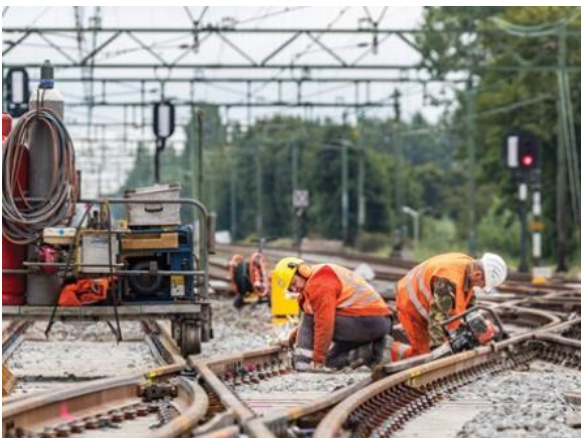
Tijdelijke verlenging onderhoudscontracten spooraannemers (bron: prorail.nl)
