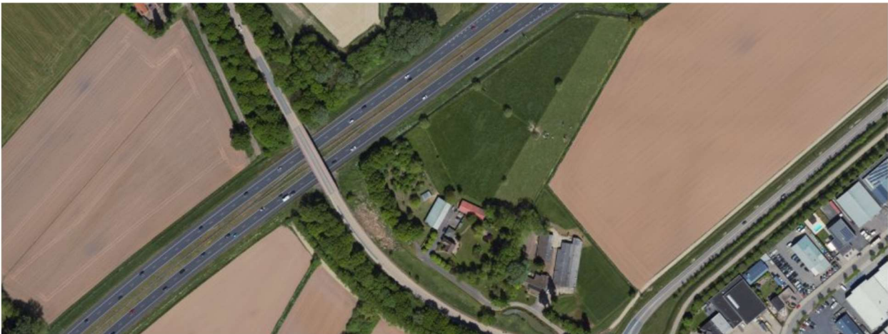
Figuur 7.5.7. Woningbouw bij 137,2
