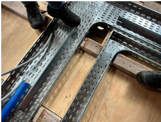
Proefopstelling leidingen en kabelgoten voor elektra
