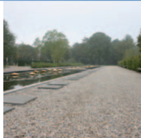
Duomix fundering onder granulaat paden
