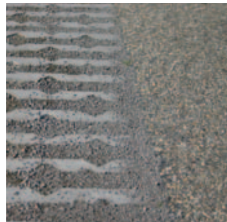
Duomix fundering onder grasbetonblokken
