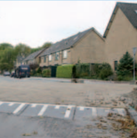
Duomix onder verkeersdrempels
