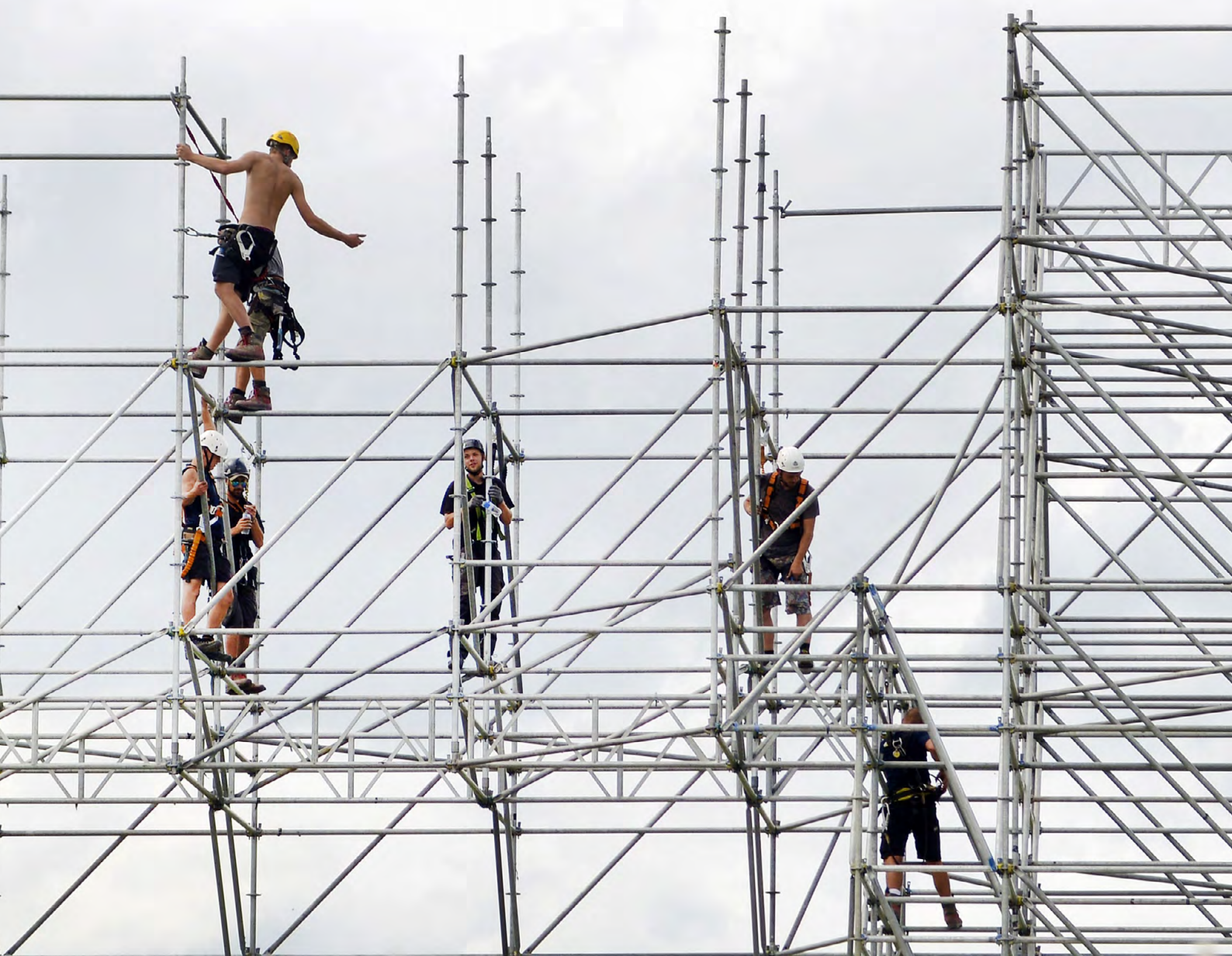
Steigerbouwers werken aan de opbouw van het podium voor een festival. Foto: ANP/Hollandse Hoogte, Flip Franssen
