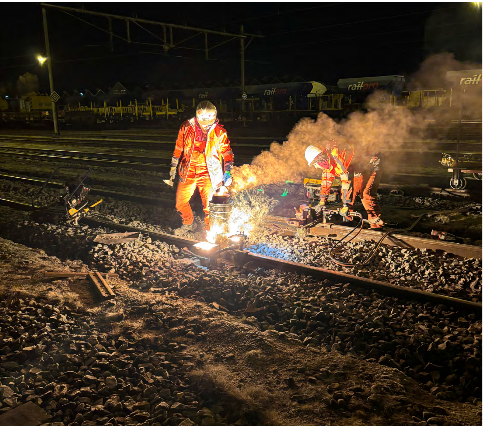
Nachtwerk aan het spoor. Foto: Nederlandse Arbeidsinspectie
