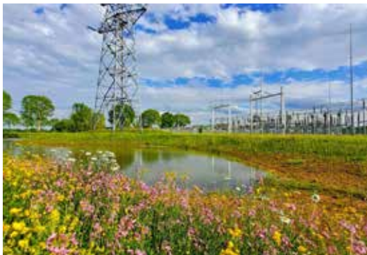
Referentie: onderstation Nijmegen Inpassing onderstation i.c.m. waterberging
