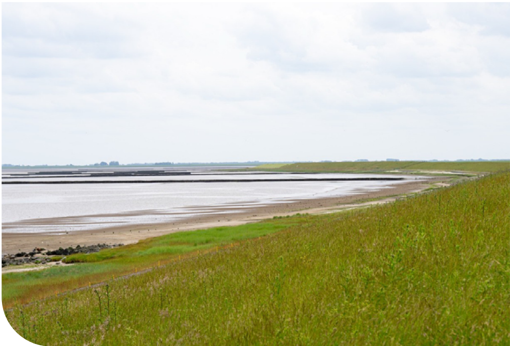
De groene dijk langs de Eems-Dollard. De dijk wordt versterkt met klei van eigen slib, om hem sterker én groener te maken.
